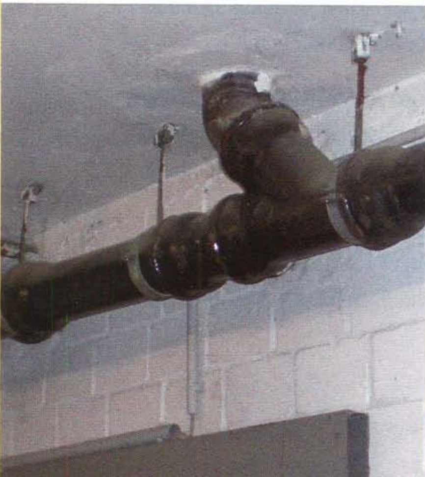
Abhängen der Leitungen unter der Kellerdecke
